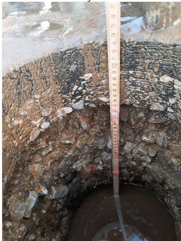
Rysunek 1 Konstrukcja nawierzchni bitumicznej
